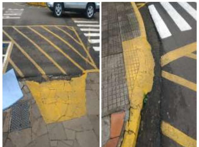
Fig. 18. Rampa e rebaixamento afastados da faixa de travessia de pedestres. Fonte: os autores.
