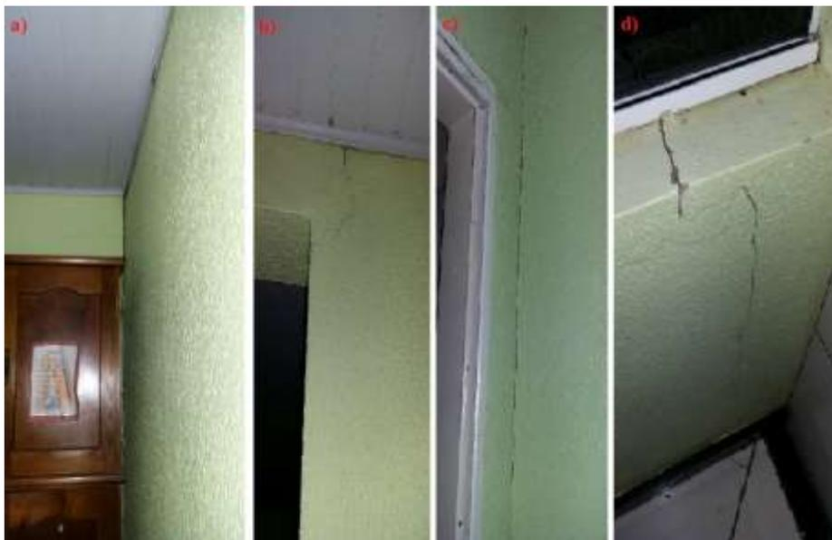
Fig. 5 – a) Fissura 02 – vertical no dormitório; b) Fissura 03 – entrada da sala; c) Fissura 04 – porta do dormitório; d) Fissura 05 –
