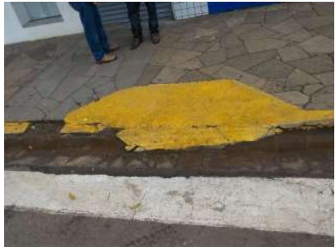
Fig. 16. Rebaixo deteriorado e sem planos inclinados. Fonte: os autores.
