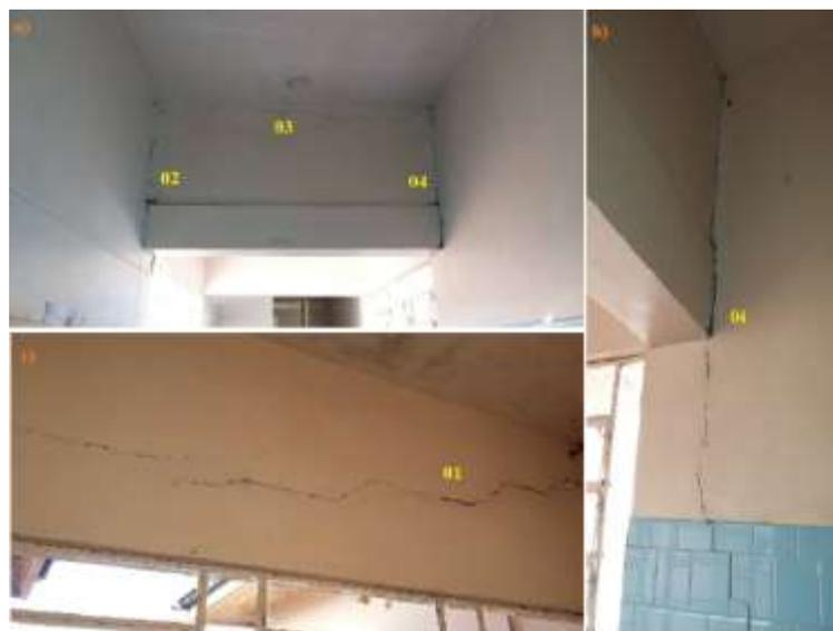
Fig. 1 – a) Fissuras Horizontais e Verticais; b) Detalhe da Fissura 04; c) Detalhe da Fissura 01
