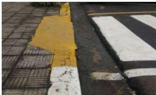
Fig. 6. Valeta de escoamento pluvial. Fonte: os autores.
