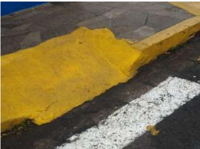
Fig. 15. Rampa inclinada e escorregadia. Fonte: os autores.
