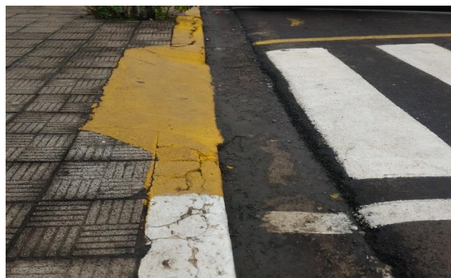
Fig. 6. Valeta de escoamento pluvial. Fonte: os autores.
