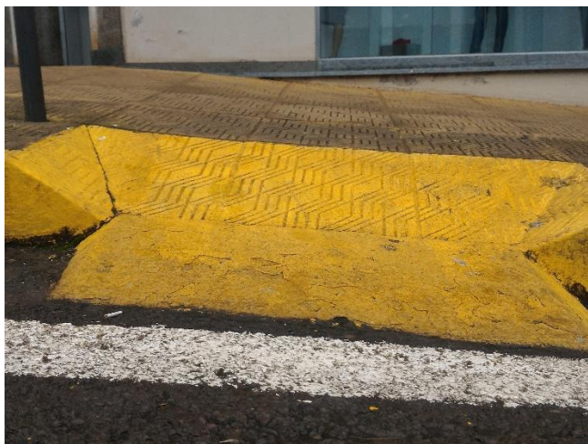
Fig. 14. Rampa inclinada. Fonte: os autores.
