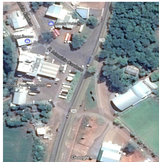
Fig. 7. Acesso Secundário ao Município em Vista Superior
